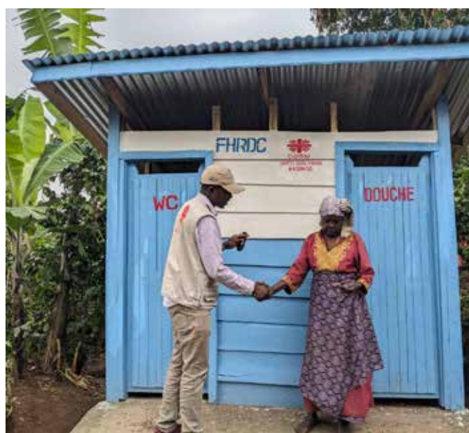
Construction des toilettes et douches d'urgence dans la ZS de Minova, Aire de santé de Kasunyu. Remise de l'ouvrage à une bénéficiaire - Projet CBPF-DRC-25-R-NGO-35517
